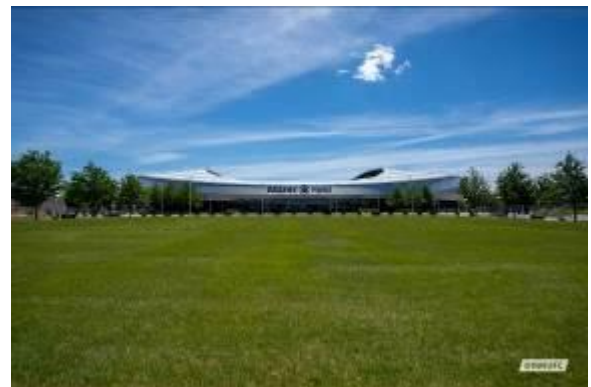
ピッチを掘り込み、地盤レベルに対して高さを抑えた計画
