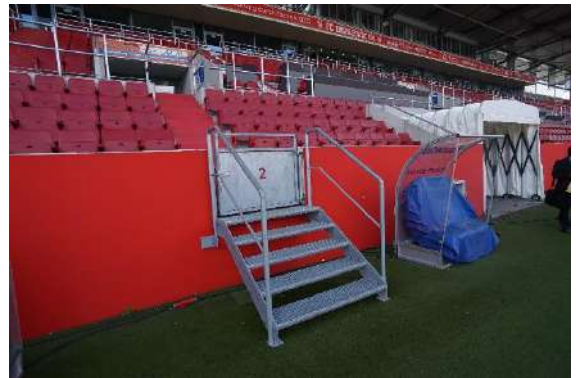
スタンドからピッチに即座に降りることが可能な避難動線
