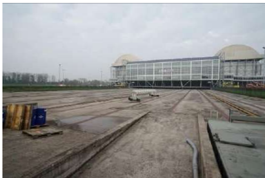
スタジアム南側のピッチ引き出しスペース
