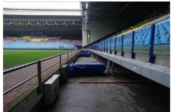
内側から見た引き出し口
