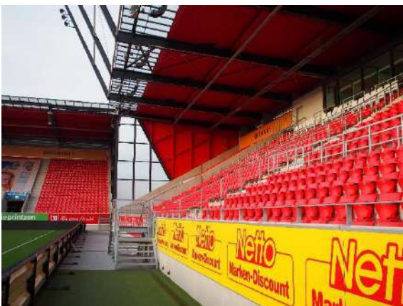
スタンドからピッチに即座に降りることが可能な避難動線
