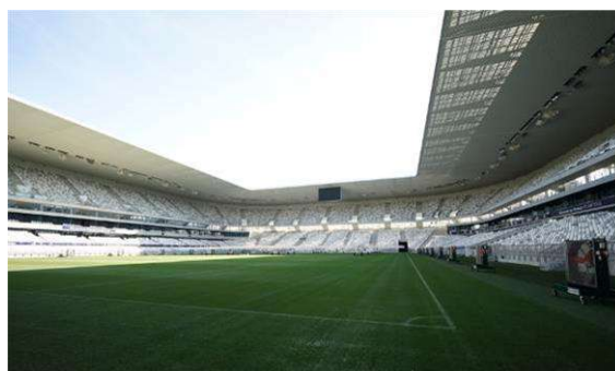
2層式スタンドで構成されたスタジアム内部
