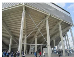
スタジアムを支えるコンクリートの柱
