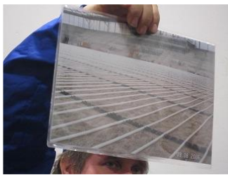
全長約25kmに及ぶ芝暖房用の配管
